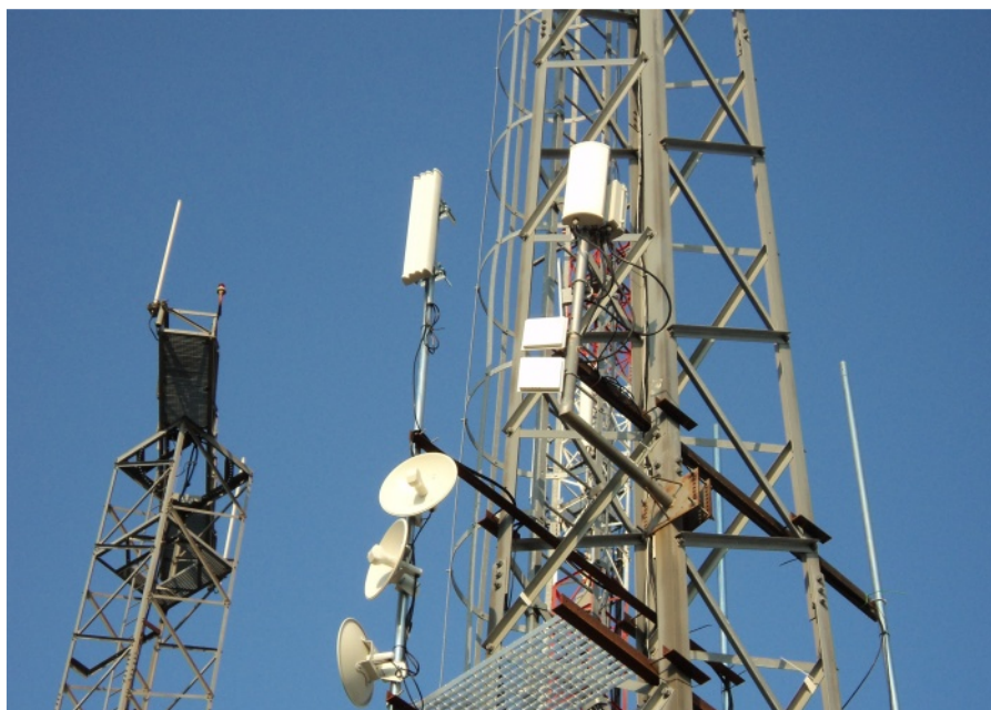
Antenes de guifi.net instal·lades al repetidor
